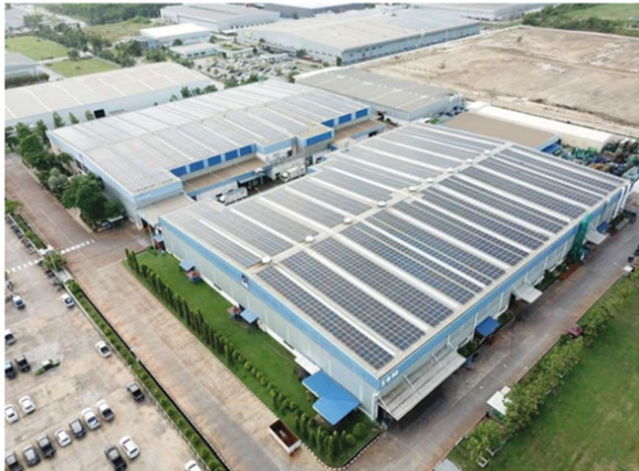
รูปที่ 3 ภาพติดตั้งพลังงานไฟฟ้าแสงอาทิตย์ SBM Plant ขนาดกำลังผลิตติดตั้ง 2.1 MW
