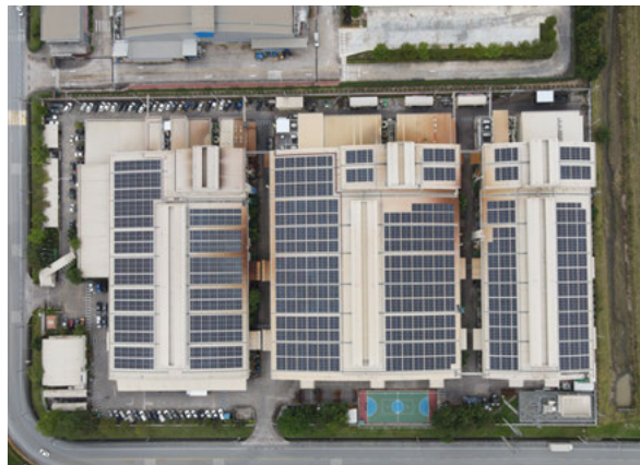
รูปที่ 4 ภาพติดตั้งพลังงานไฟฟ้าแสงอาทิตย์ SAT-2 Plant ขนาดกำลังผลิตติดตั้ง 1.5 MW
